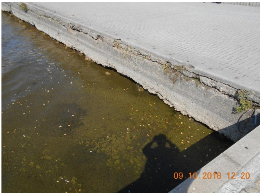
Слика 54 Постоечки бетонски ѕид
